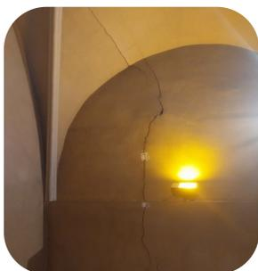
Une fissure a été repérée au niveau de la tribune de l'église. Des devis sont en cours afin de planifier les travaux de réparation dans les meilleurs délais.
