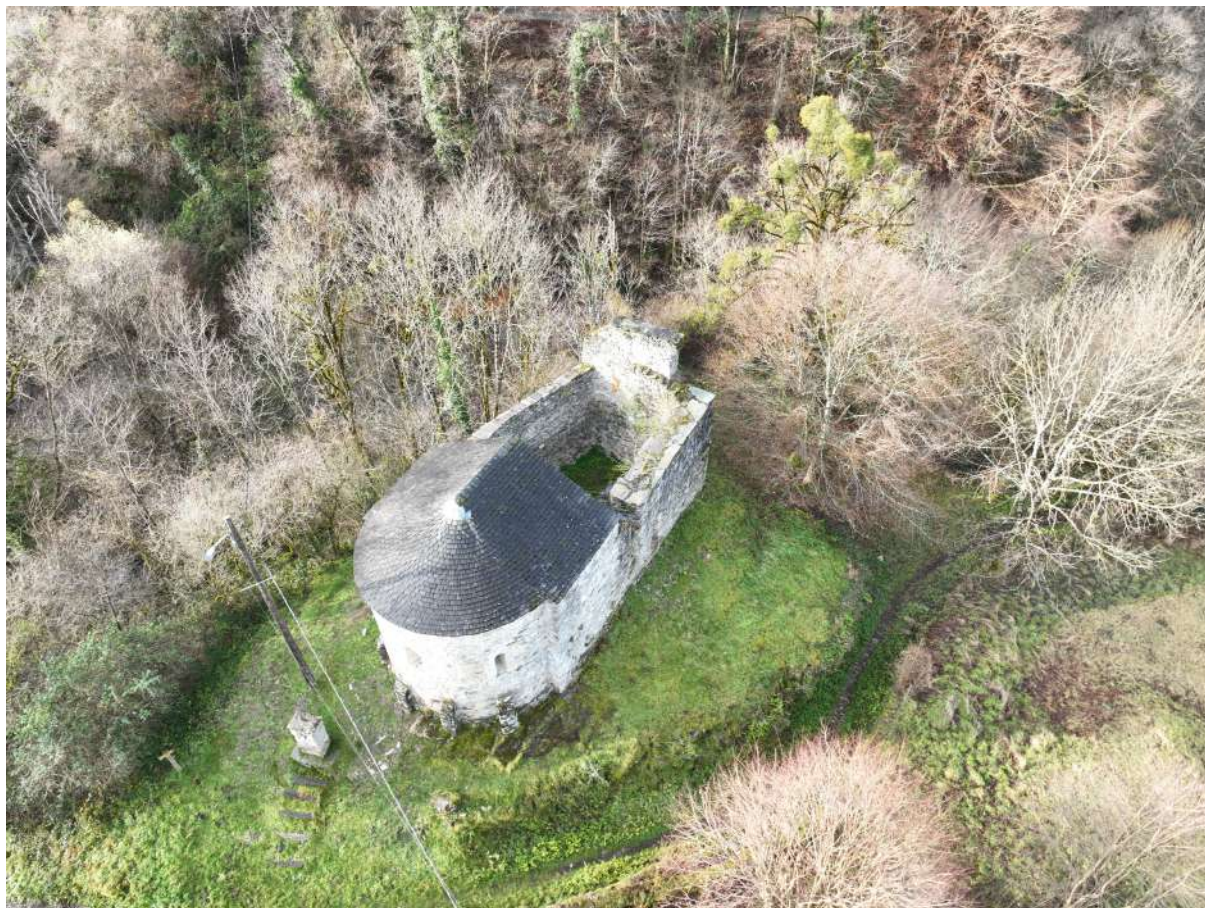
Fig. 1 : Vue aérienne de la chapelle Saint-Martin
